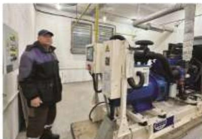
«Это на случай, если вдруг выйдет из строя электроснабжение. Автоматически, в течение 7-10 секунд включается дизель-генераторная установка, которая дает питание на полосу, ведь аэропорт должен быть открыт на прием и вылет самолетов в любое время» – рассказывает Кружлик Петр Петрович.
